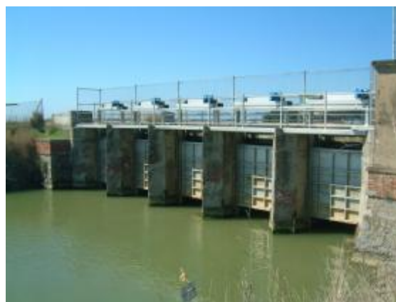
Fig. 8.5.1 Meccanismo manuale di manovra delle paratoie Fibbia/Albegna prima dei lavori
