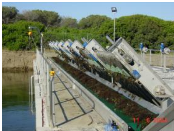
Fig. 8.4.1 Impianti di grigliatura automatica di Ansedonia in fase esecutiva
