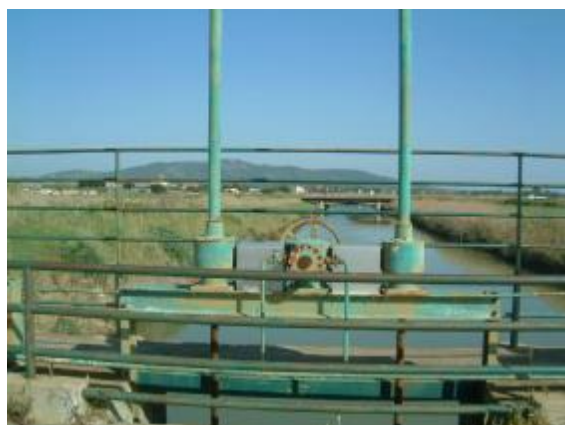
Fig. 8.5.1 Meccanismo manuale di manovra delle paratoie Fibbia/Albegna prima dei lavori
