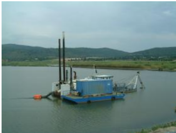
Fig. 11.3 Dragaggio dell'area conterminata
