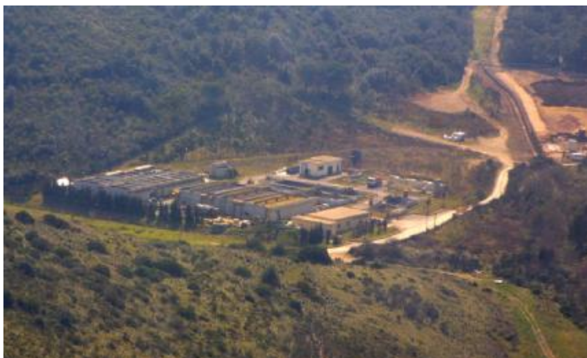
Fig. 9.2 Veduta aerea dell'impianto di depurazione di Terrarossa nello stato attuale
