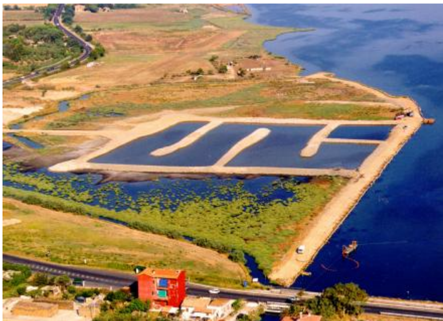
Fig. 11.11 La nuova cassa di colmata di Terrarossa in fase di completamento
