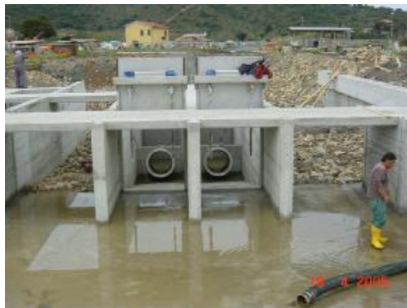
Fig. 8.2.1 Impianto di Nassa: opere in c.a. per l'alloggiamento delle nuove idrovore
