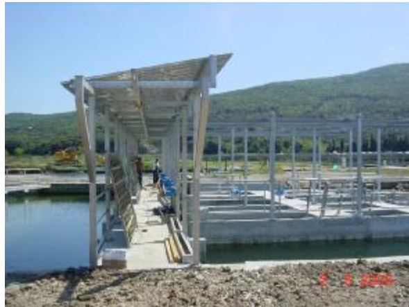
Fig. 8.2.1 Impianto di Nassa: opere in c.a. per l'alloggiamento delle nuove idrovore
